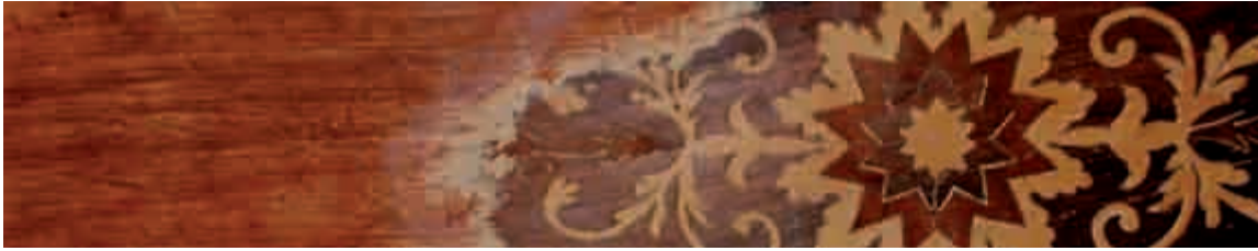
Eliminació d'un repintat
